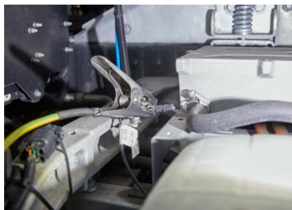
Une liaison équipotentielle appropriée permet d'éviter les décharges électrostatiques.
