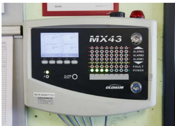
Des systèmes d'avertissement de gaz avertissent de la présence de concentrations de gaz explosives.
